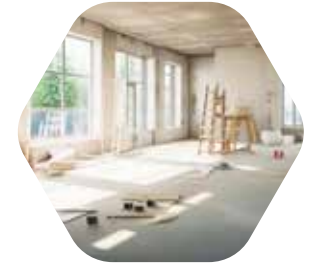
REMODELACIÓN Y RENOVACIÓN
